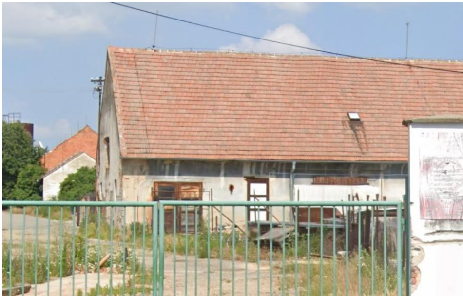
Obr. 23 – hospodářská stavba - kravín Hrušky (foto J. Drozda)
