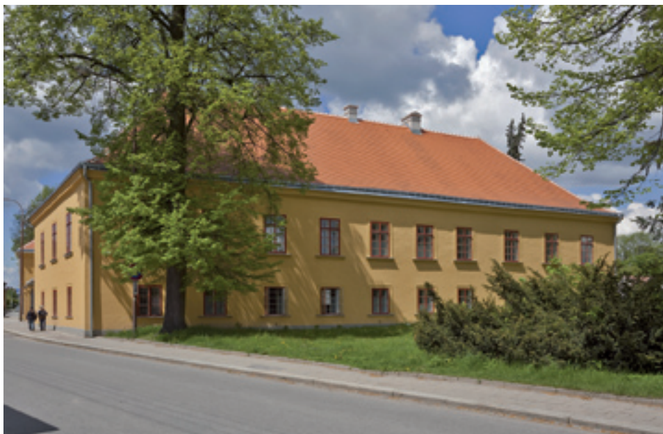
1 Východní křídlo bývalého dispenzáře, pohled z Hradecké ulice. Zdroj: foto V. Mašát, NPÚ ÚOP Telč (2013).
