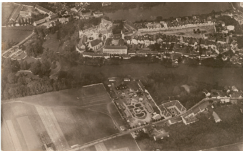
10 Letecký snímek areálu s plochou výstaviště, přestavěným dispenzářem a zahradou, 1922. Zdroj: soukromá sbírka autorky.
