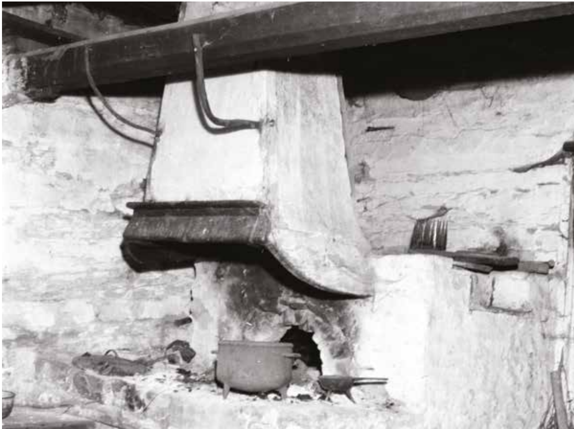
Ukázka černé kuchyně s topeništěm místo: Zázrivá, okres Dolný Kubín; datace: 1960; zdroj: Sbíрка NZM
