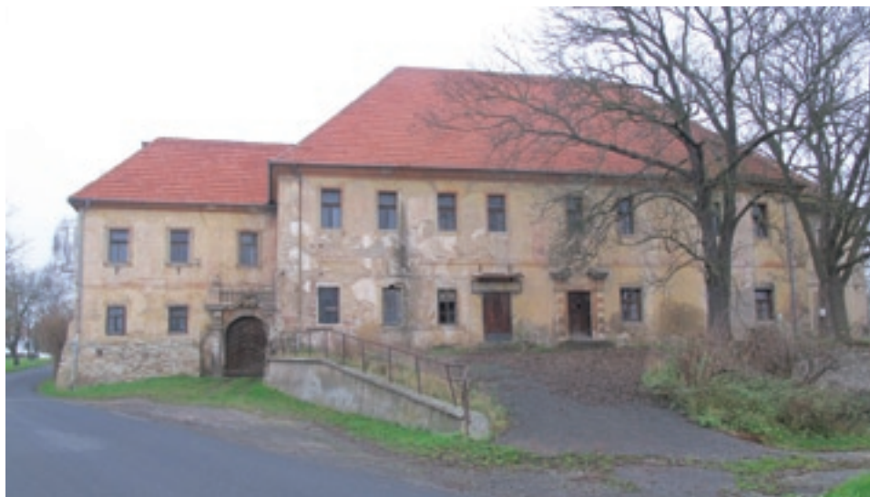
Záhořany, torzo úpravy parteru. Zdroj: foto P. Novák (2017).
