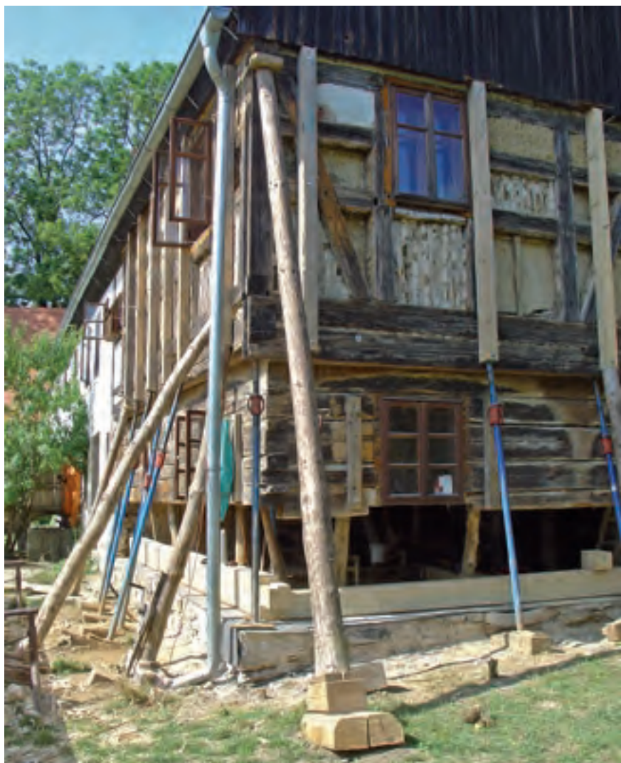
Obr. 12. Podvádění roubenky a výměna podstávky v Jindřichovicích p. Smrkem (archiv autora).
