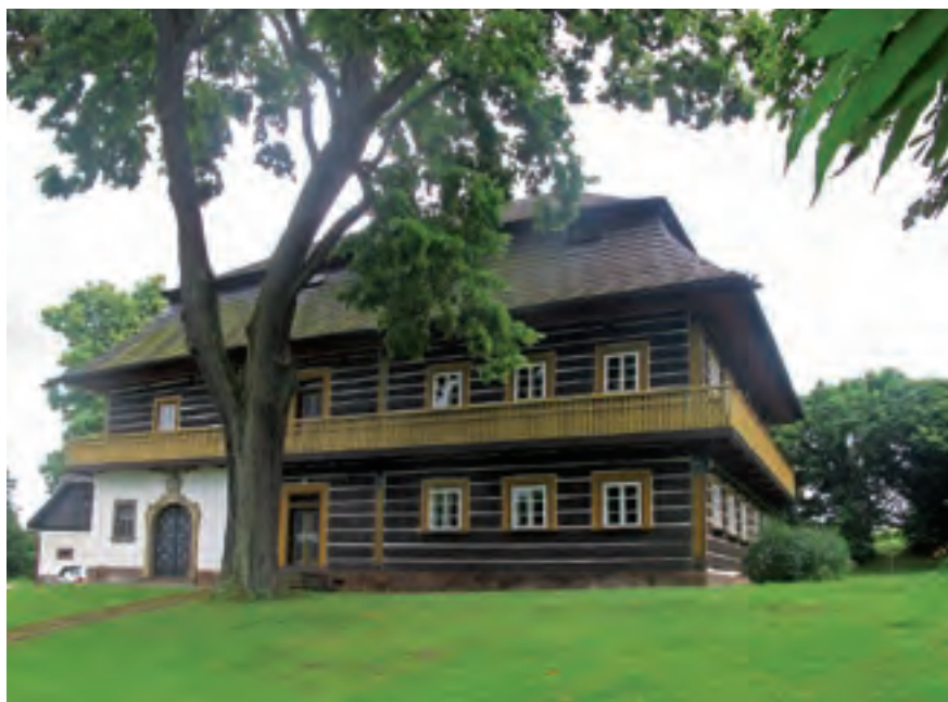
Obr. 1b. Tuláčkův statek v Kruhu u Jilemnice – současný stav (foto autor 2015).
