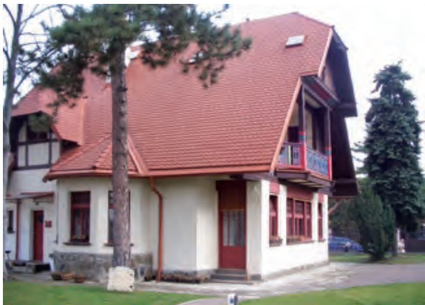
Obr. 4. Praha-Strašnice, Trmalova vila, 1902–1903, pohled od SZ (archiv autorky).
