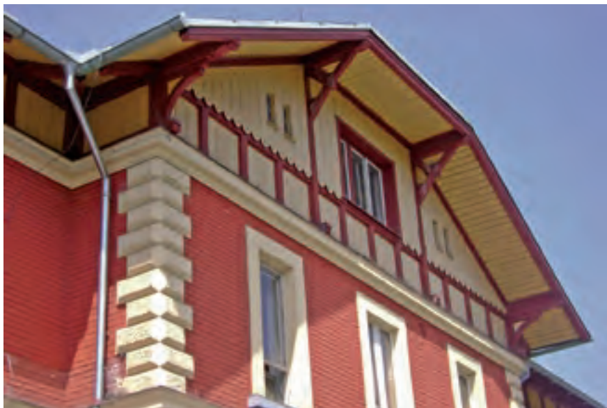
Obr. 8. Typické „nádražní“ chování krovu, uplatňované u nás od konce 19. století (foto autor).
