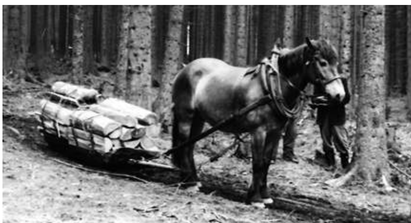
Obr. 3.11 Soustřeďování rovnaného dříví člunem za jedním koněm bylo oblíbené, neboť bylo pro kočího pohodlnější než soustřeďování surových kmenů nízkých hmotností. (Archiv autora)
