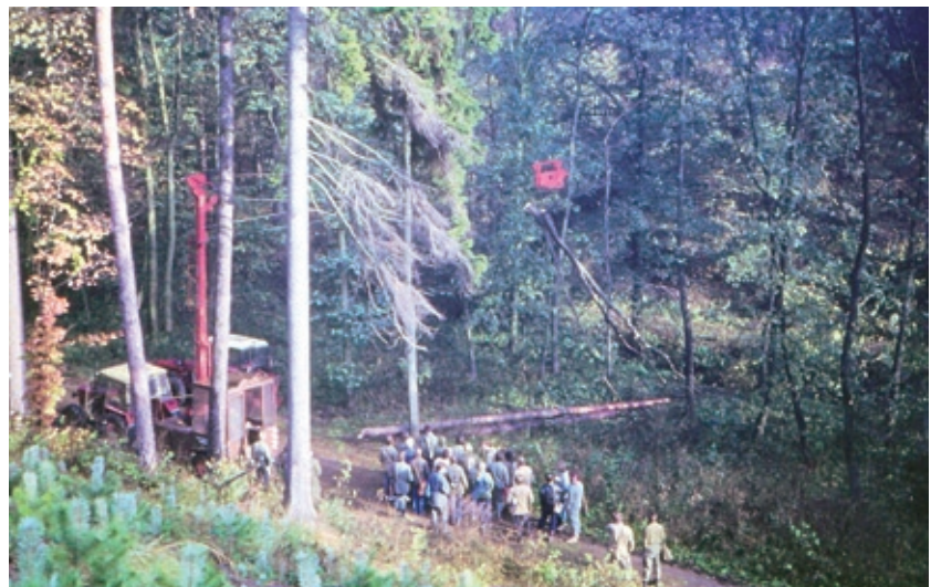
Obr. 3.135 Kvalitativním skokem byl v roce 1991 stožárový systém LS 2-500 z VS Křtiny se čtyřbubnovým navijákem a motorickým napínáním nosného lana, postavený na přívěsu za UKT. (Archiv autora)
