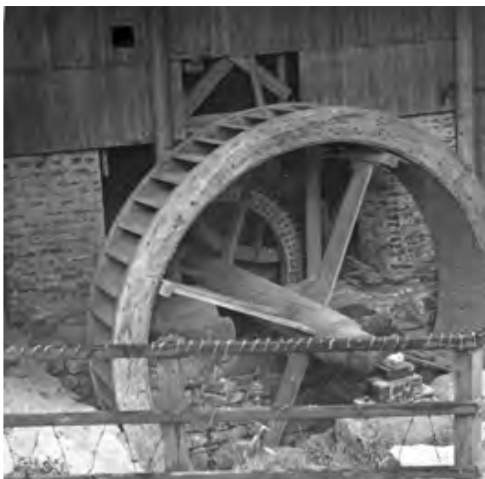
13 Stoupa na kosti a vodní kolo na horní vodu, majitel A. Doleček v Klášterci nad Orli., postaveno 1893–1898, 1958. Zdroj: autor Z. Tempír (i. č. 31 059).
