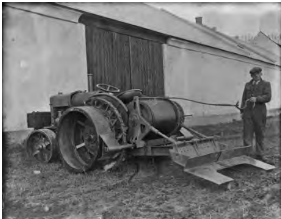
4 Traktor Škoda 18HP s navijákem pro krtčí drenáž, 1931. Zdroj: získáno od Státní výzkumné stanice zemědělské v Libějovicích (i. č. 5916).
