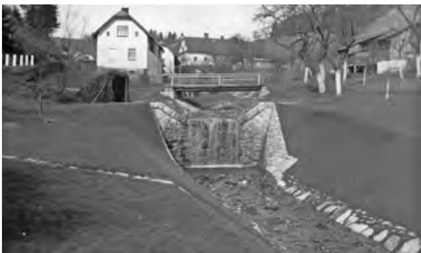
10, 11 Hrazení bystřin v Nové Vsi u Vizovic – stav před zahrazením a po něm, [1921]. Zdroj: NZM, fond Archiválie, OF Jaroslav Lemberg, inv. č. 109/1.
