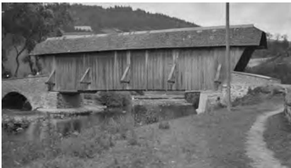
12 Krytý dřevěný most přes řeku Svatku, vystavený roku 1865, pohled podélný po opravě, 1931. Zdroj: autorka L. Špičková Vandasová.
