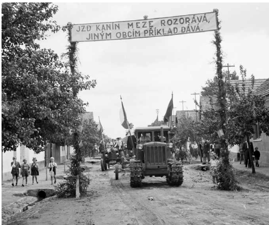
14. Průjezd obcí traktorem DT-54 při orání mezí v JZD Kanín.
