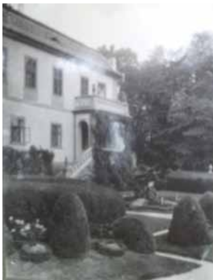
18. Zámecká terasa se zděnou verandou a balkónem. Výstavba proběhla v roce 1928. Zdroj: SOA Praha, fond Rodinný archiv Götzlů, Praha.
