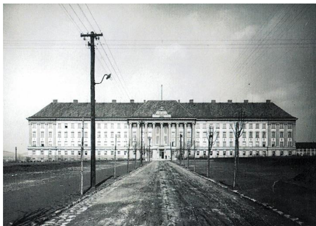
Obr. 38 budova Vysoké školy zemědělské v Brně, 1920
