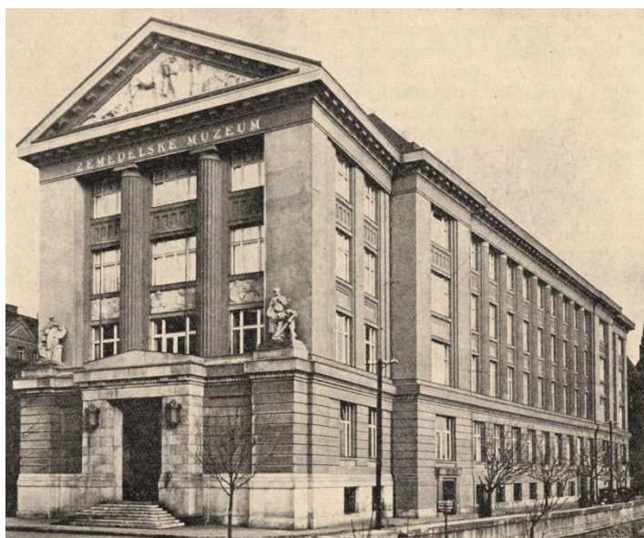
Obr. 53 nová budova pobočky ČZM v Bratislavě, 1930
