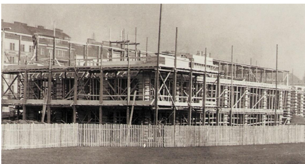
Obr. 68–70 dokumentace postupu stavebních prací na budově ČZM v Praze na Letné, 1938
