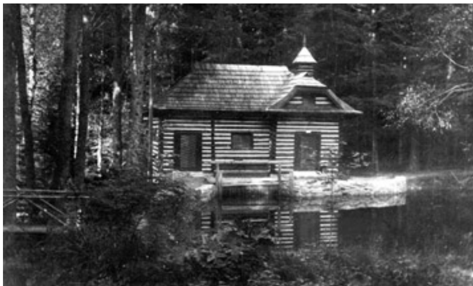
9 Stavba elektrárny respektovala tradici brdských roubenek. Zdroj: archiv Václava Jiříčky.
