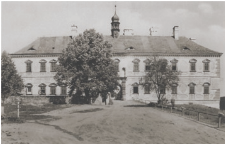
11 Zámek Rataje nad Sázavou. Zdroj: archiv Miloše Hořejše.
