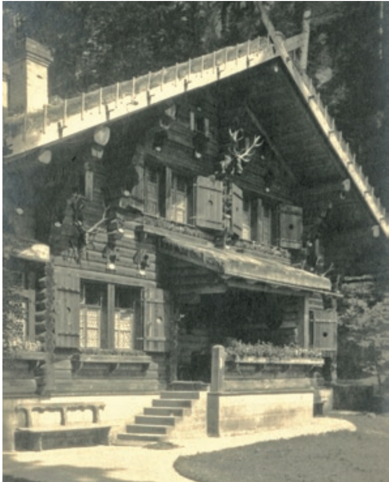
12 Detail čelní stěny panského domu na Tokáni. Zdroj: SOA Zámorsk, fond RA Kinských, Heřmanův Městec.
