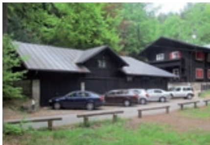
D. Garáže a stáje. Zdroj: foto autor 2014.
