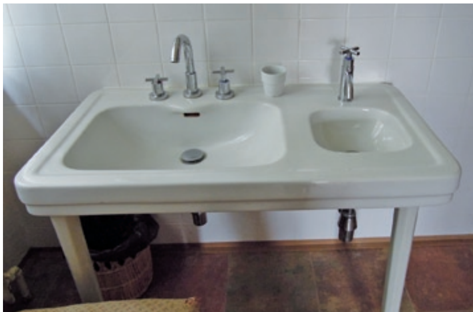
14 V některých koupelnách je dodnes zachovalá i sanitární keramika z let 1941–1943. Zdroj: foto Hana Šantavá.
