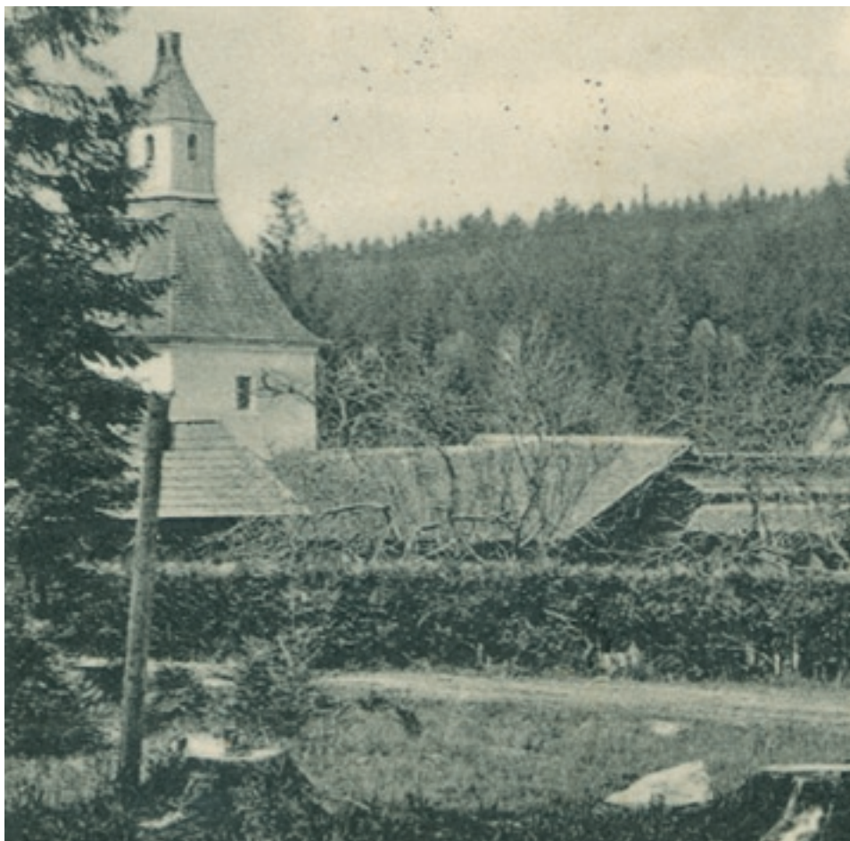
7 Pohled na kapli „Lesního usmíření“ s dřevěnou budovou kočárovny. Výřez z dobové pohlednice. Datováno do roku 1930. Zdroj: archiv autora.
