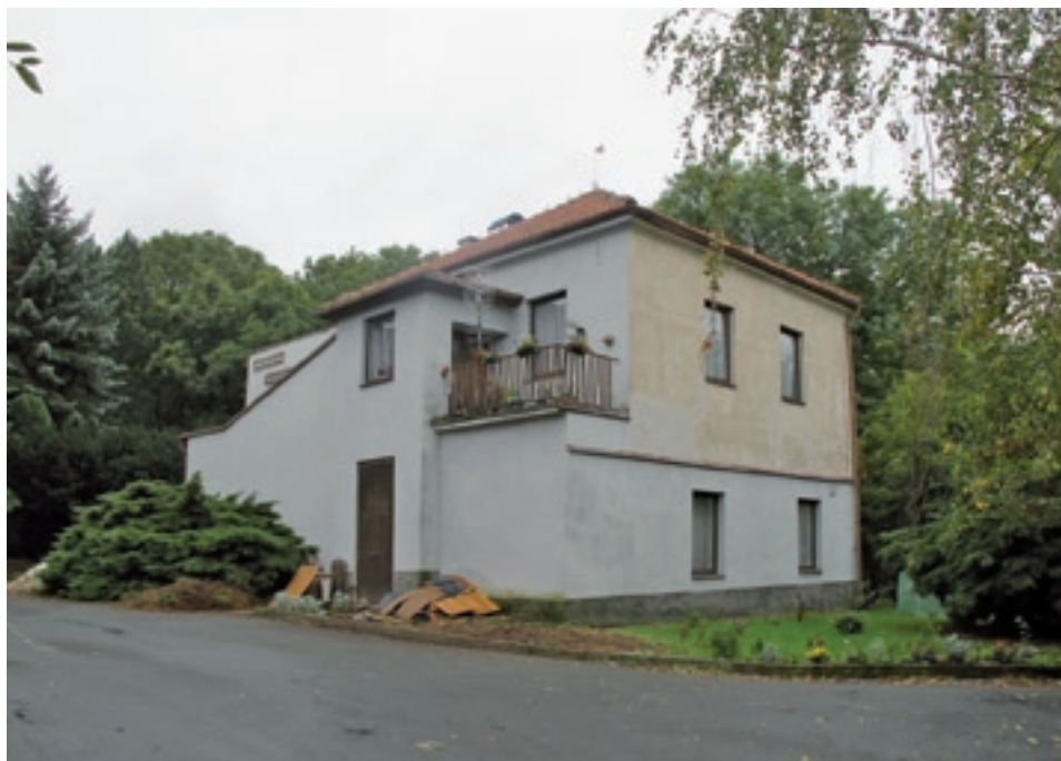
12 Tzv. zámček v Opatovicích. Zdroj: foto autor 2016.
