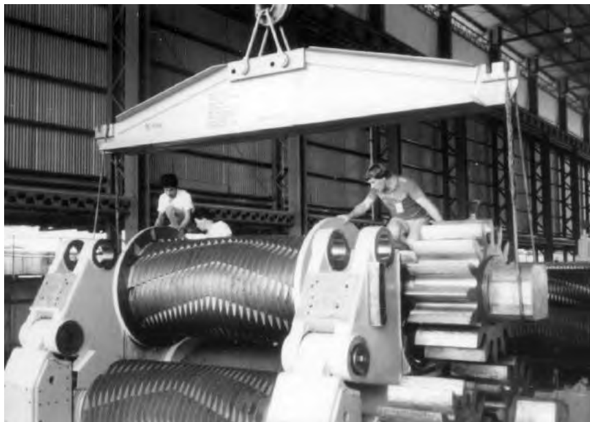
24/ Montáž horního mlýnského válce. Dnes používaná úprava horního válce pro vtahování třtiny do mlýna, snímek z roku 1989, archiv Jaroslava Bartoška
