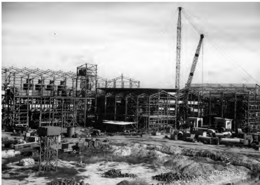
08/ Cukrovar KANTALAI na Cejloně. Cukrovar v montáži, celkový pohled zezadu, snímek z roku 1959, archiv Jaroslava Bartoška
