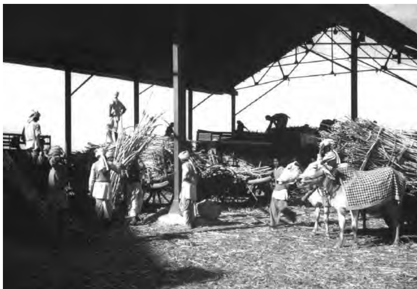
2/ Cukrovar PANIPAT v severní Indii – skládka třtiny. Ruční skládání z bývolích kár a nákladních aut na třtinový dopravník, snímek z roku 1957, archiv Jaroslava Bartoška
