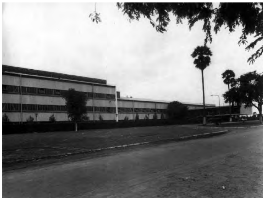
13/ Rafinérie PALMOVÉHO CUKRU v Kambodži. První cukrovar tohoto období projektovaný ve spolupráci s architekty, což zlepšilo celkový vzhled, ale i vnitřní řešení. Rafinérie Kambodža byla zničena Rudými Khmery, snímek z roku 1964, archiv Jaroslava Bartoška
