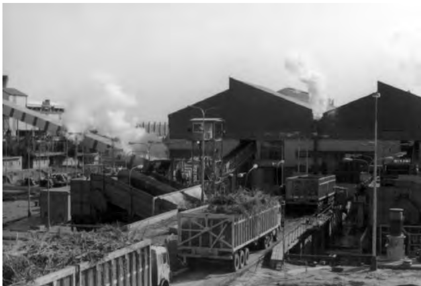
16/ Cukrovar KARUN v Íránu (Khuzestan). Skládka třtiny pro jednu ze tří paralelních extrakčních stanic. Sváží se speciálními vozy, každý s obsahem 40 tun třtiny, snímek z roku 1972, archiv Jaroslava Bartoška
