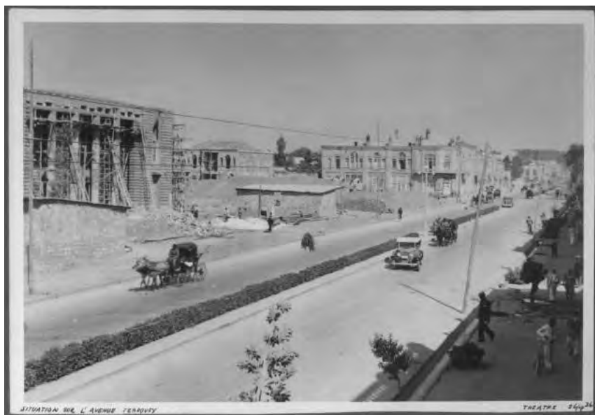
1/ Výstavba divadla v Teheránu, Archiv Škoda, a. s., Plzeň
