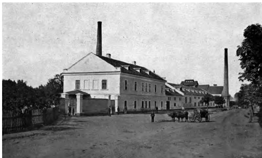
04/ Cukrovar Ovčáry z roku 1872 od severní strany ze silnice
