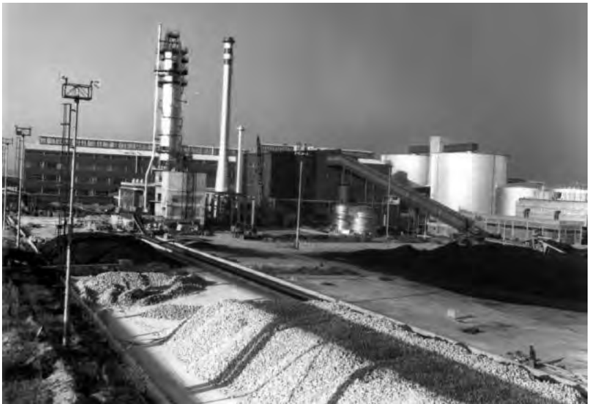
23/ Cukrovar ŠABAC v Jugoslávii (Srbsko), pohled ze zadní strany: vápenka a kotelna s příslušnými ukládkami, hlavní budova a síla na cukr, snímek z roku 1985, archiv Jaroslava Bartoška
