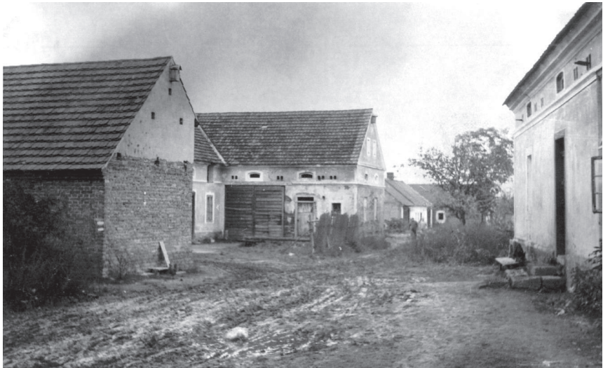
Neosídlené usedlosti určené ku zbourání. AV Plzeň
