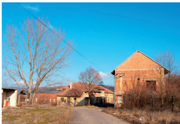
Současný stav justičního statku Mikulov, archiv autorů
