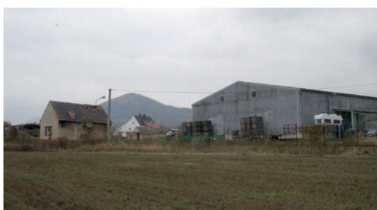
Současný stav justičního statku Mlékojedy, archiv autorů
