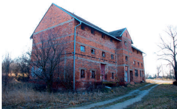
Současný stav justičního statku Mikulov, archiv autorů
