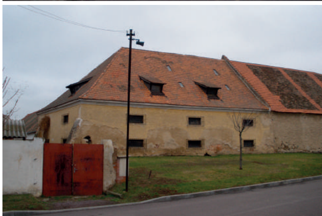
Současný stav justičního statku Chvalovice, archiv autorů
