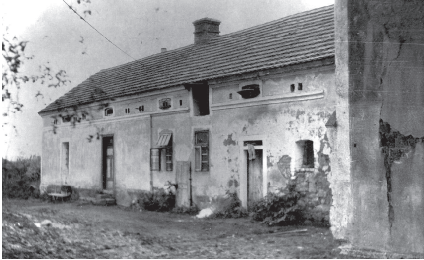
Neosídlené usedlosti určené ku zbourání. AV Plzeň
