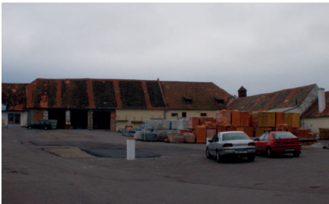
Současný stav justičního statku Chvalovice, archiv autorů
