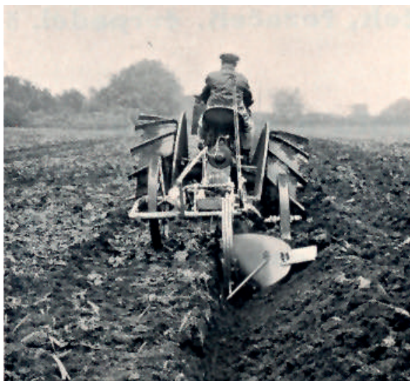
Archiv NZM, f. Firemní literatura, traktor Škoda 30, hluboká orba jednoradličným pluhem
