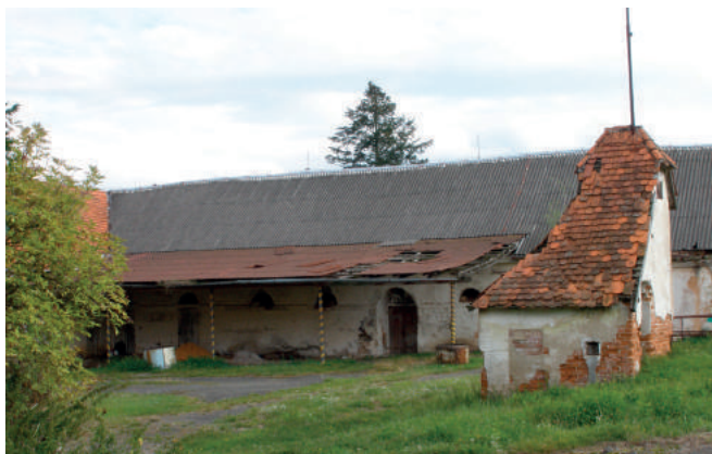
Současný stav justičního statku Nedražice, archiv autorů
