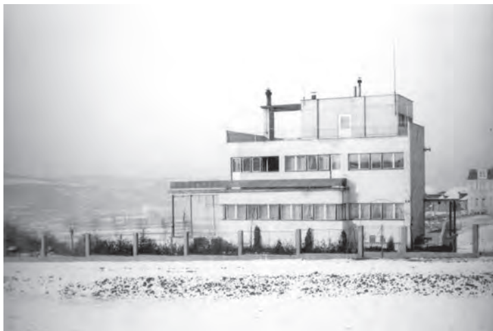
Uliční průčelí vily F. Langera s nově založenou zahradou, 30. léta 20. stol. , zdroj: Památník národního písemnictví, Praha, fond František Langer
