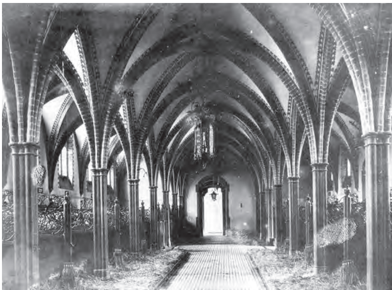
Interiér stáje ve východním křídle, pohled směrem k jižnímu vstupu, poč. 20. stol., SZMO, fotoarchív, sig. A 12.026
