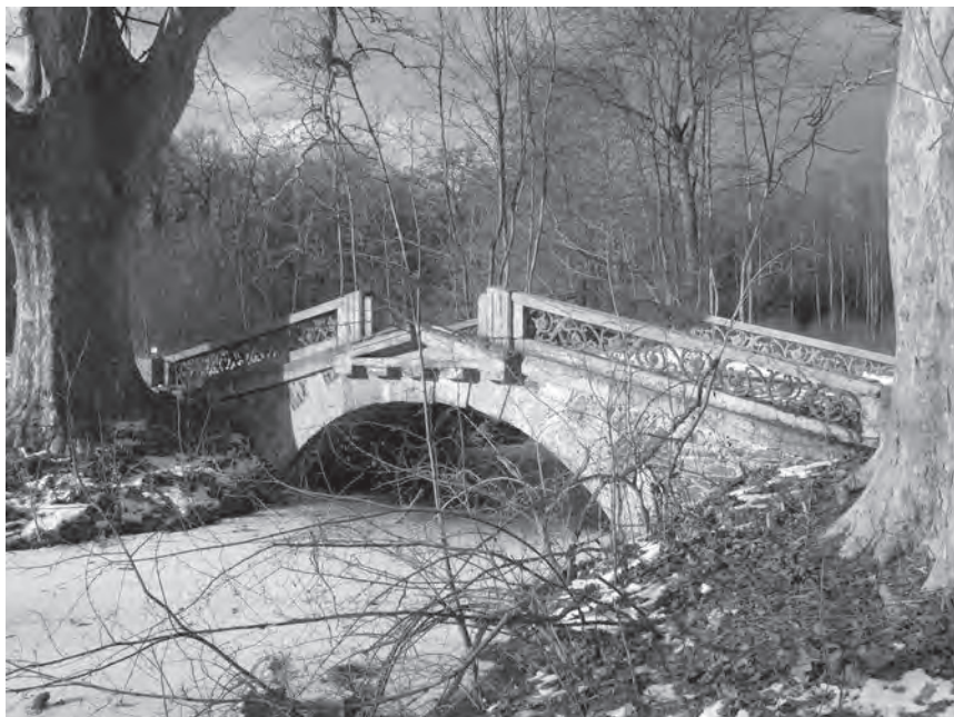
Současná podoba Platanového mostku po sejmutí zbývajících litinových delfinů ze zábradlí. Foto Martin Vlček, NZM Kačina
