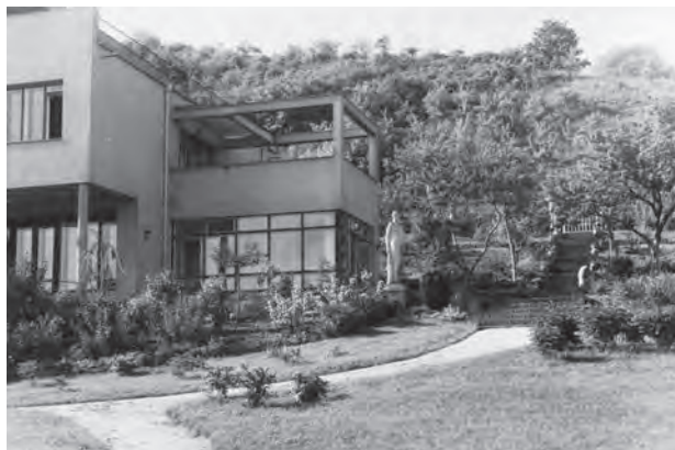
Jihovýchodní průčelí vily A. Schücka s prosklenou verandou a sochou na terase, 30. léta 20. stol. , zdroj: Uměleckoprůmyslové museum v Praze, fond Josef Sudek, sig. GF 56116
